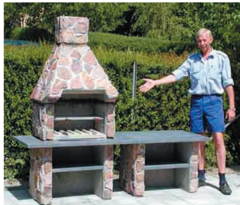
En stolt formand præsenterer det færdige resultat med den nye grill installeret og klar på legepladsen.
