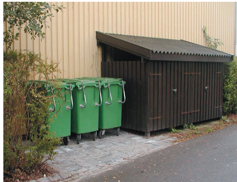
Den nye "containerplads" ved nordgavlen
